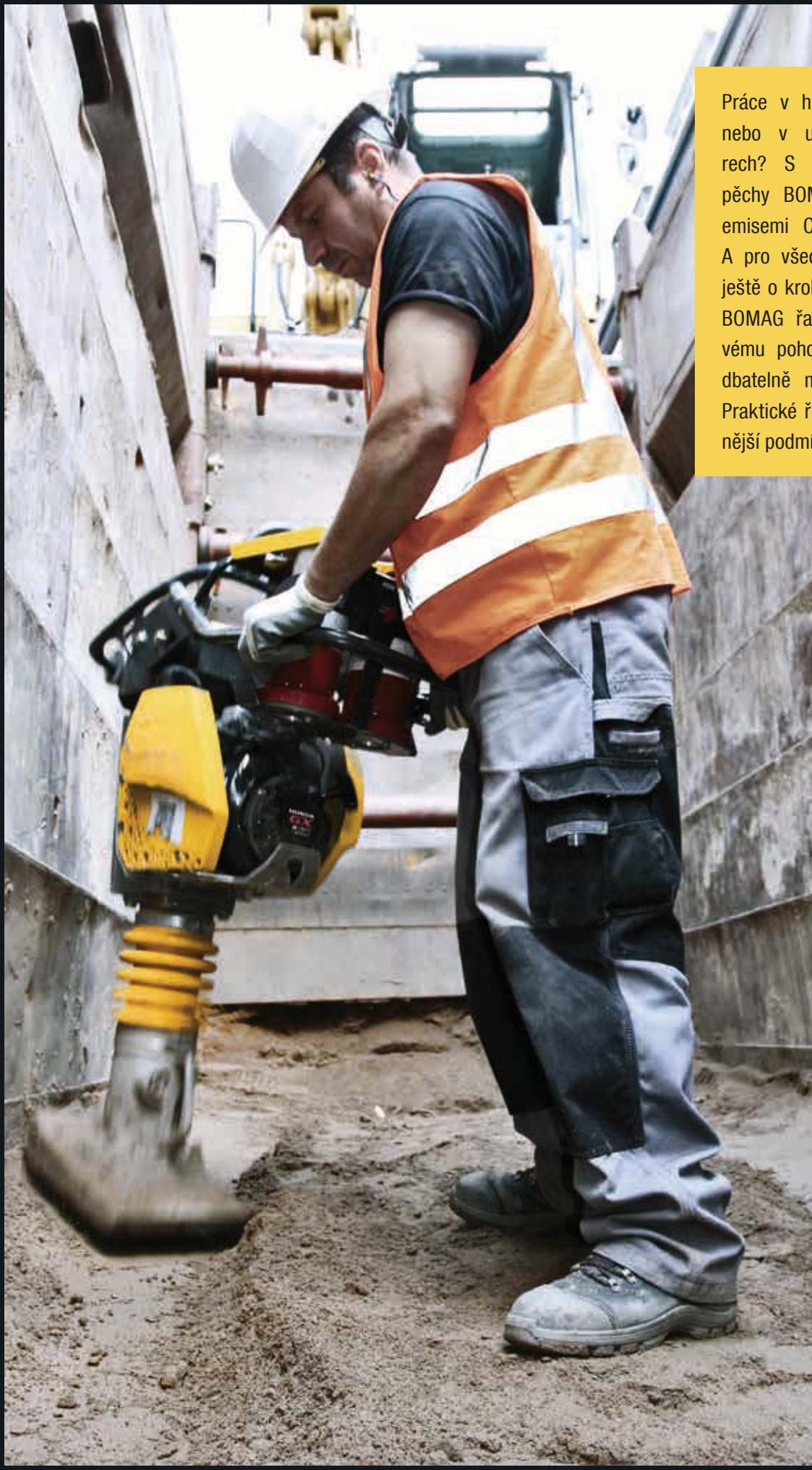
Práce v hlubokých výkopech nebo v uzavřených prostorách? S novými vibračními pěchy BOMAG se sníženými emisemi CO žádný problém. A pro všechny, kdo chtějí jít ještě o krok dál, jsou tu stroje BOMAG řady G. Díky plynovému pohonu dosahují zanebatelně malých hodnot CO. Praktické řešení pro nejnáročnější podmínky nasazení.
